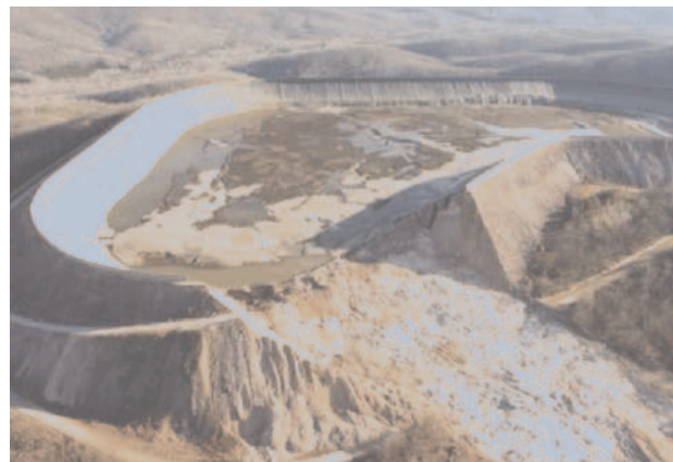
Fig. 3. El embalse superior de Taum Sauk (Missouri, USA), antes y después de su rotura en diciembre de 2005.
